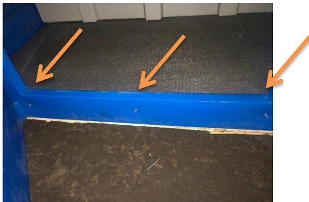
10. Далее внутри кабины заклепать задние боковые ребра по длине от бака до верха кабины.
