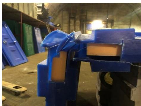
3. Просверлить отверстия в стыковых пазах панели и вставить вытяжную заклепку «лепестковую». Заклепывать необходимо сразу после сверления отверстия. На данном этапе скрепляются 3 панели.
