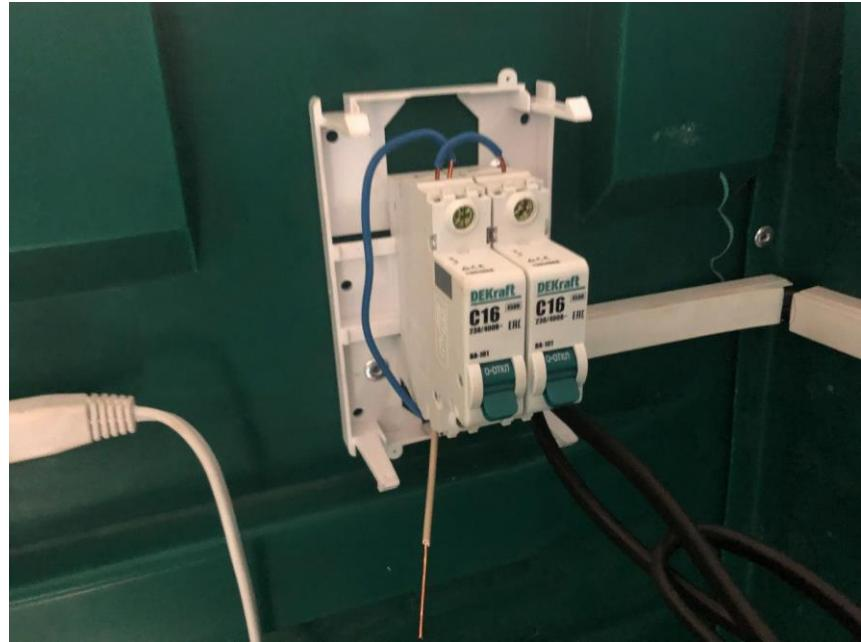
Далее оголяем провод от обогревателя и подключаем к автомату снизу.
