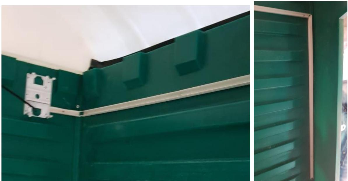
Слева от короба ставим выключатель и ведем провода от него к выключателю. Также в короб закладываем провод для конвектора тепла и ведем к автомату. Далее закрываем короб.
