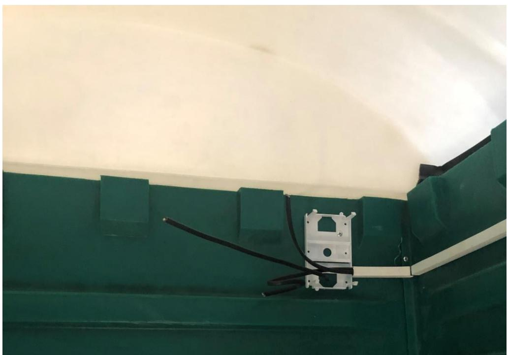
Далее крепим конвектор тепла: снаружи и внутри правой стенки на уровне 6 (шестого) ребра жесткости крепим пластины, ставим крепеж для конвектора, а потом сам конвектор
